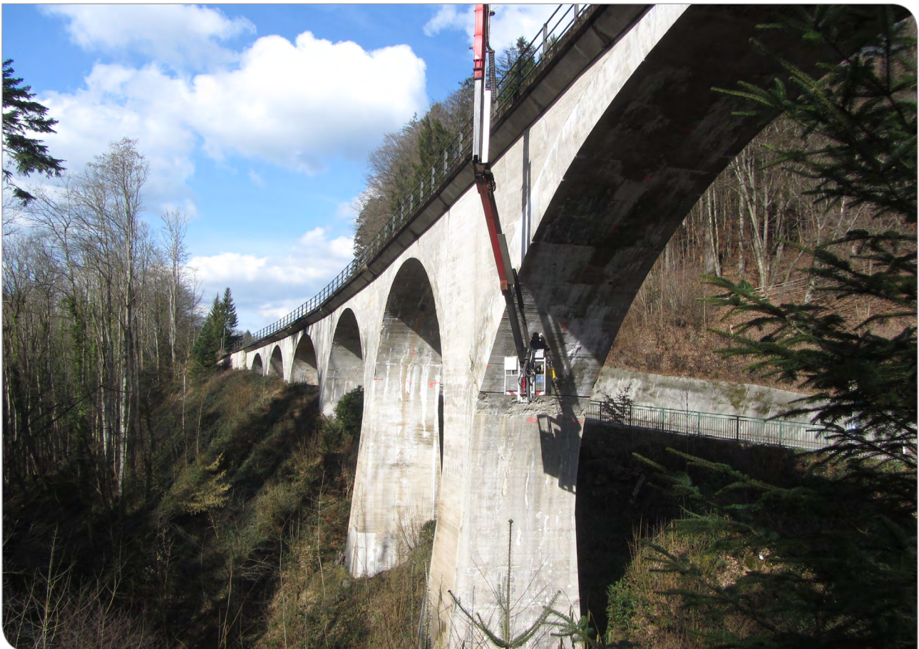
Durchführung von Zustandsaufnahmen per Radar und Ultraschall von einer mobilen Arbeitsbühne aus.
